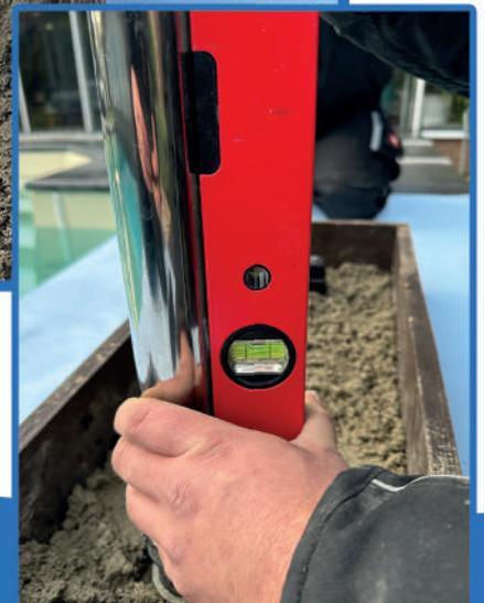
4. Den Kasten mit Beton auffüllen, die Leiter mit den Montagehülsen einbetonieren und Glatt Streichen.
