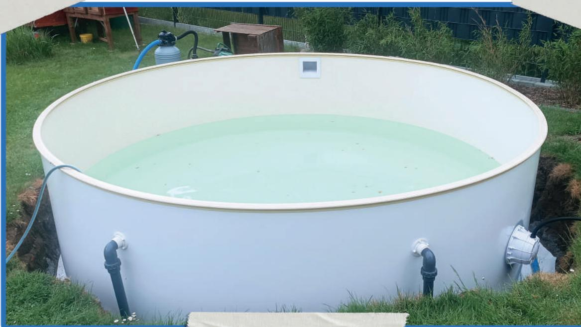
Die verbauten Teile, wie **Düsen und Skimmer** müssen Sie nun mit der **Filteranlage verbinden**. Dabei hilft Ihnen das **einfache Stecksystem**.
