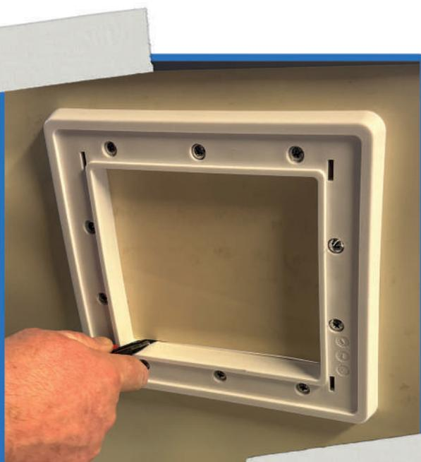
Nun kann die **Skimmerklappe** im Innenraum befestigt werden. Zudem die **Schraubenblende in der Innenseite einsetzen**.
