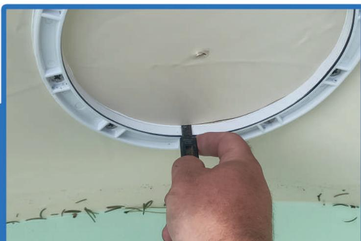
Nachdem die Folie ausgeschnitten wurde, wird das Kabel durch die **Verschraubung** gefädelt. Sobald dies erledigt ist, muss das ganze mit einer **Zange** **verschraubt** werden. Als Gegenprobe zur Sicherstellung, kann etwas an dem Kabel gezogen werden.
